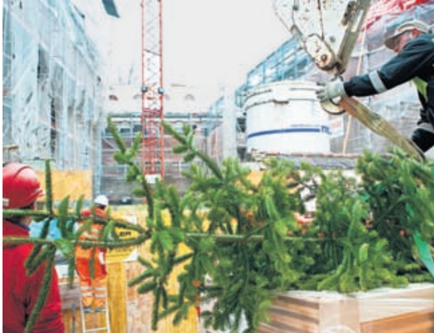
Der Baum ist bereit. Die Aufrichtefeier fand gestern statt, nachdem ein Brand die Bauarbeiten im vergangenen August verzögert hatte. Foto Maria Stratmann
