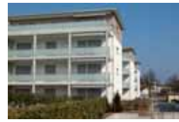
4 Grossmatt3, Bettlach 46 Miet- und Eigentums- wohnungen www.grossmatt.ch
