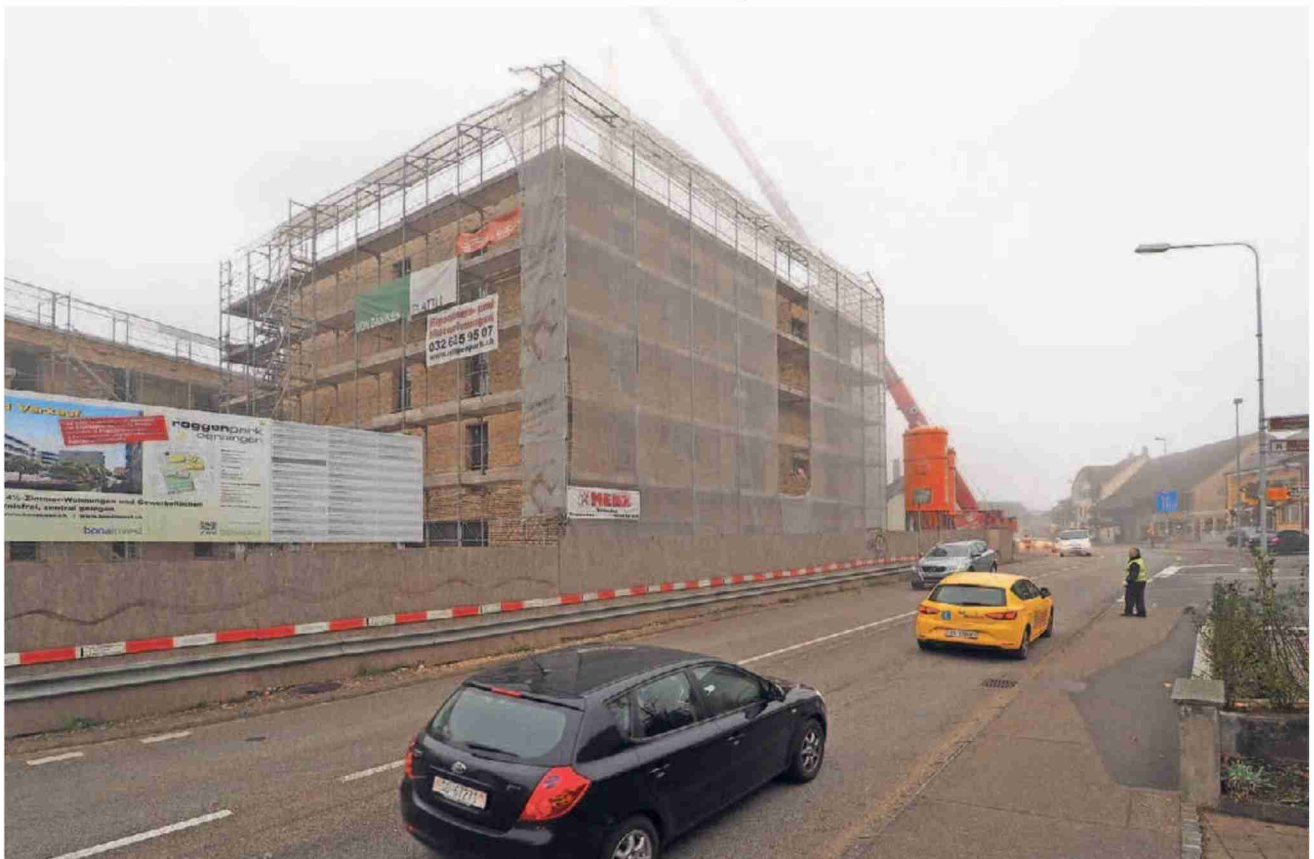
Die Hauptstrasse muss im Bereich Schlosstrasse/Sternenweg stellenweise bis zu 30 Zentimeter abgesenkt werden.
