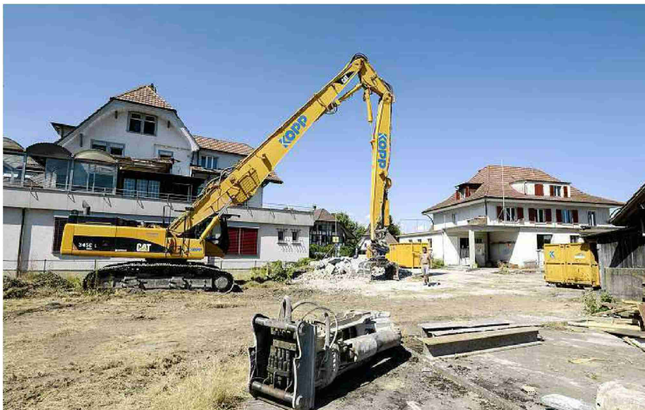
Der Bagger für die Abbrucharbeiten im Utzenstorfer Zentrum ist schon aufgefahren. Diese Woche wird vorbereitet, ab nächster Woche werden die beiden Häuser links und rechts dann abgerissen.
