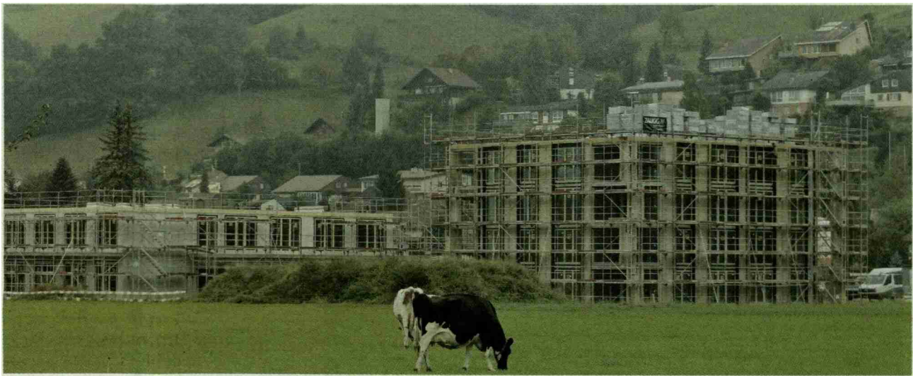
Die Gebäude des «Sunnehof» fügen sich harmonisch in die ländliche Umgebung ein. Bereits ist der Rohbau erstellt. Bild: Verena Nyfeler
