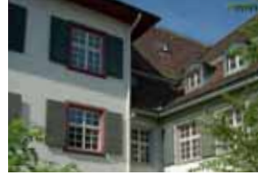
③ Basel, Andlauerhof 17 Eigentumswohnungen bonacasa®-Standard
