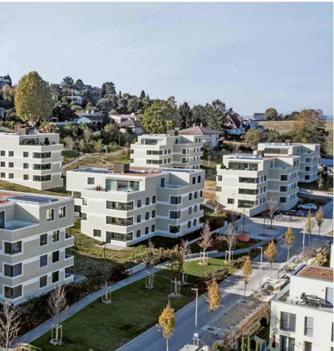
Der 2018 fertiggestellte Bellevuepark in Port erfüllt den Minergie-Standard. Die Wärmegewinnung erfolgt mittels Holzpellets und beim Warmwasser mit Sonnenkollektoren auf dem Dach.
