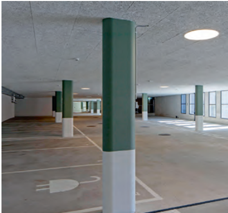
Parking souterrain de bonaLiving Ägerisee, Unterägeri
