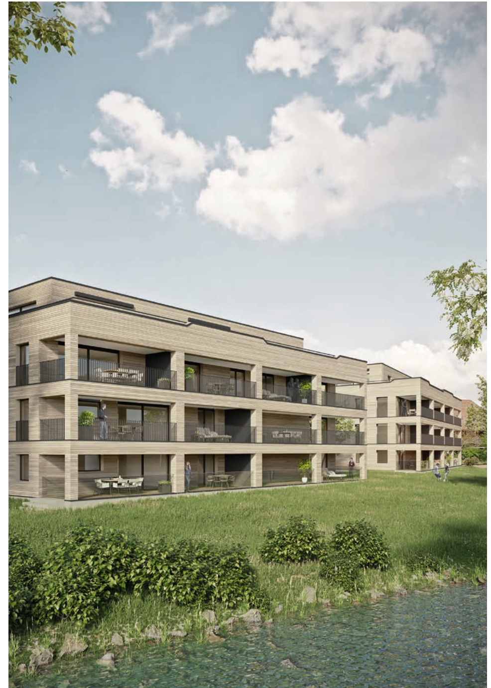
1 In Schwarzenburg entsteht an attraktiver Lage eine Überbauung mit 31 Mietwohnungen. Der Baubeginn steht noch nicht fest.
