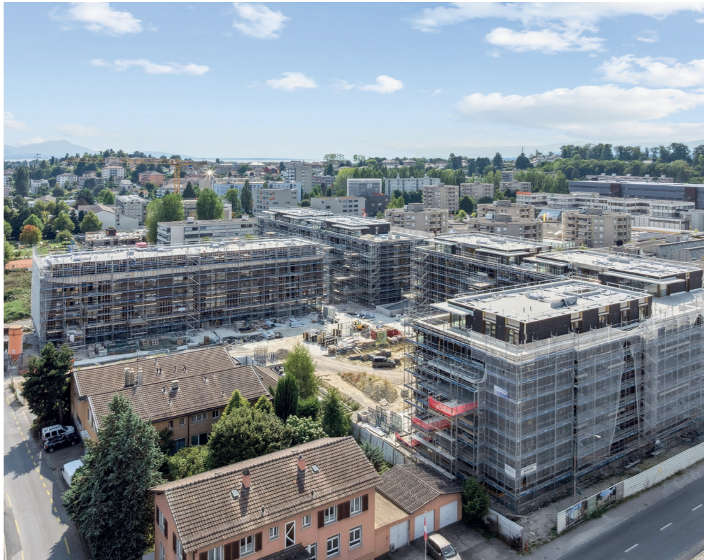
Foto: Backbone / Überbauung Mapraz Parc in Ecublens, Baustand 26.08.2025
