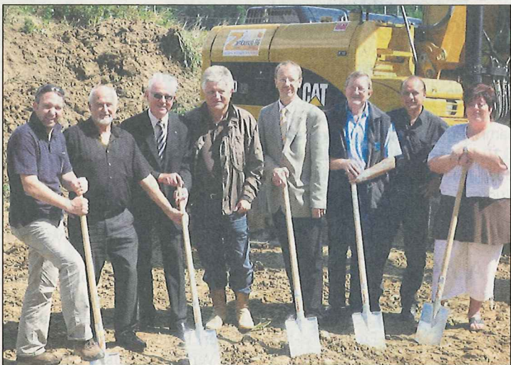
Im Lochzelgli in Luterbach entstehen 13 Eigentumswohnungen. Gestern fand der erste Spatenstich statt.
