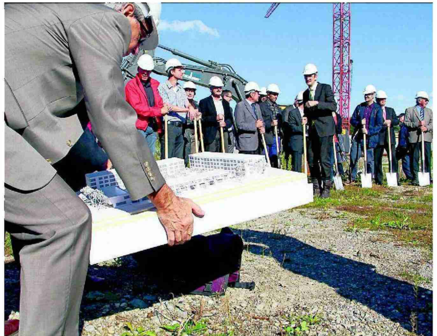
Spatenstich für 54 Wohnungen und Reiheneinfamilienhäuser.
