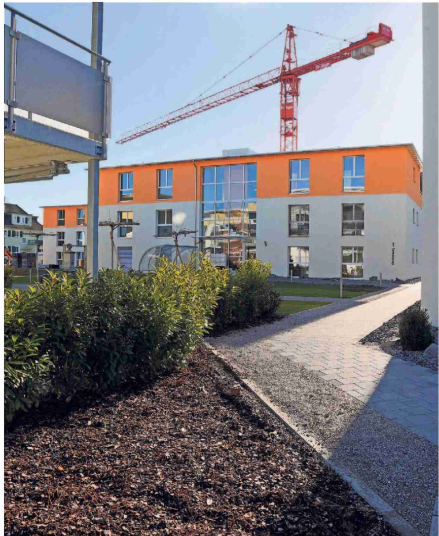
Die zweite Etappe der Überbauung «Verenapark» in Gerlafingen wird derzeit umgesetzt.
