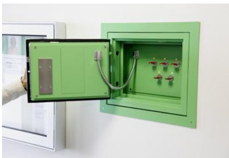
03_M_Pestalozzi_Bonacasa (5616x3744 Pixel) Schlüsselkästen ermöglichen in der Überbauung Sunnepark bei Notfällen dank temporären Zugangscodes ein schnelles Eingreifen.
