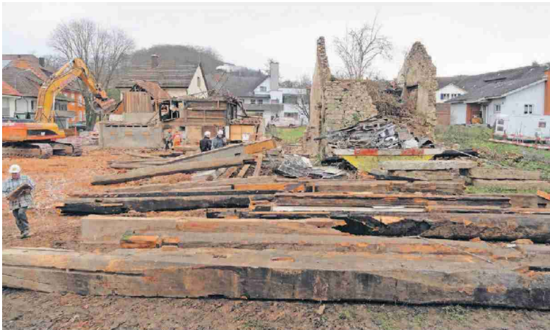
Das Hochstudgerüst ist in Einzelteile zerlegt, wie vor 455 Jahren vor dem Abbund auch schon.
