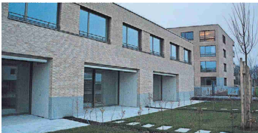
Die Stadt villen können neu gemietet werden. Der Verkauf der Eigentumswohnungen (hinten) ist in Gang gekommen.
