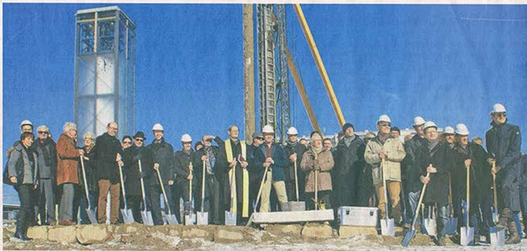
Der Baustart zum Mauritiuspark ist erfolgt. Bei Bodenfrost dienten die Spaten allerdings nur als Requisiten fürs Erinnerungsbild. (Bilder Thomas Stöckli)
