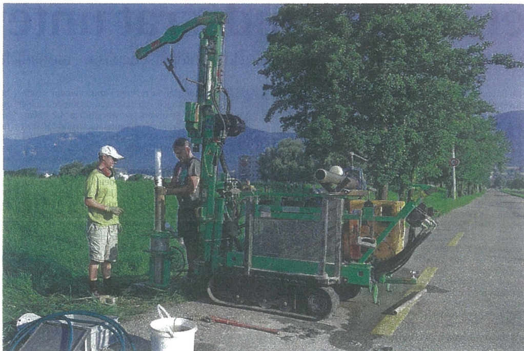
Der Solothurner Stadtmist muss saniert werden, das zeigen Untersuchungen - in welchem Umfang ist noch unklar.
