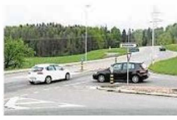
Belagsarbeiten im Bereich Moosrank müssen behoben werden. Dany Kammeler
