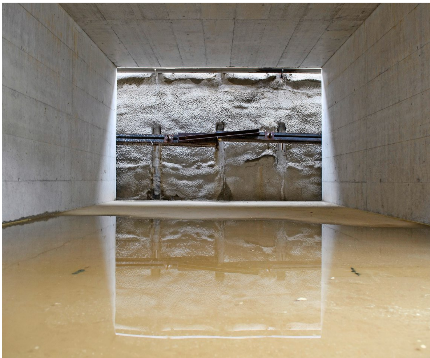
Noch gibt es in der Unterführung des neuen Bahnhofs Steinhof in Burgdorf kein Durchkommen. Fotos: Raphael Moser
