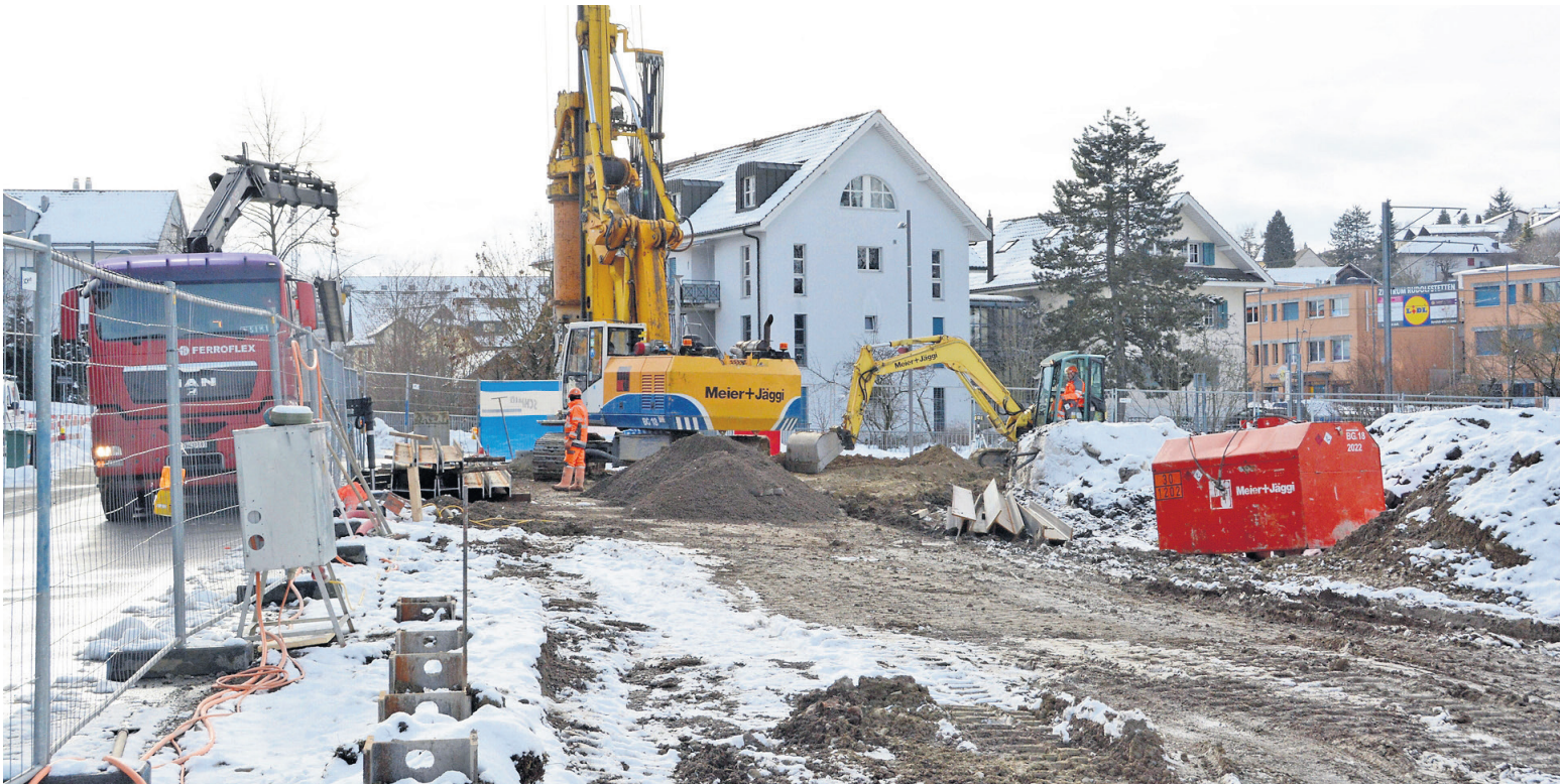
Vor Beginn der Aushubarbeiten werden mächtige Metallträger in den Boden eingelassen. Das Bohren der Löcher verursacht einigen Lärm.
