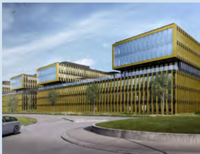
Die Überbauung Quadrolith in Baar
