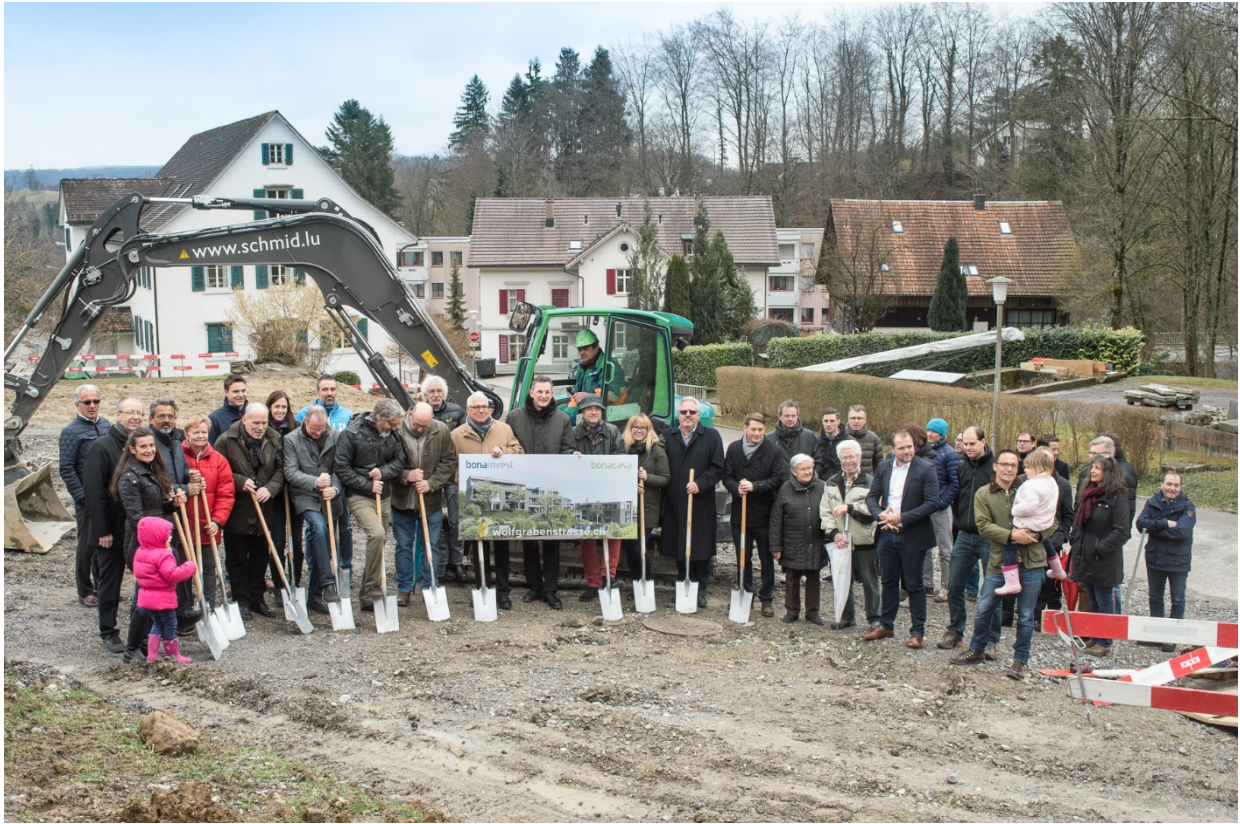
Spatenstich für die Überbauung Wolfgrabenstrasse am 7. März 2017
